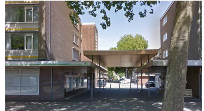
2 Westkopgevel - (Passage B)
