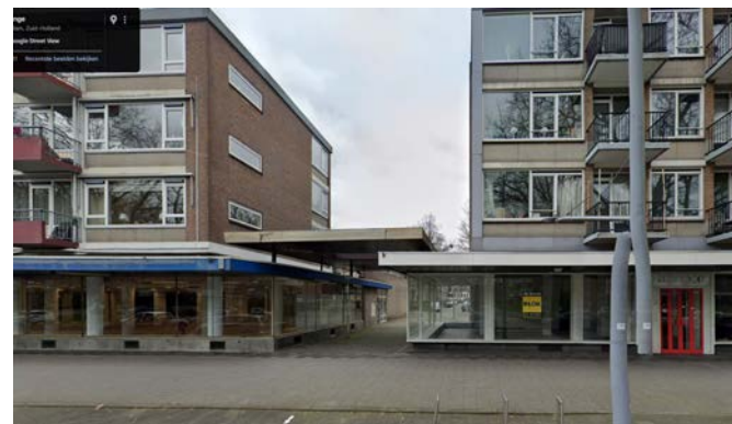
3 Oostkopgevel - (Passage D)
