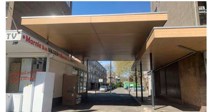
2 Westkopgevel - (Passage C)
