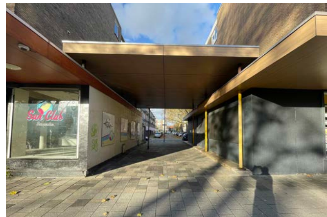
2 Oostkopgevel - (Passage A)
